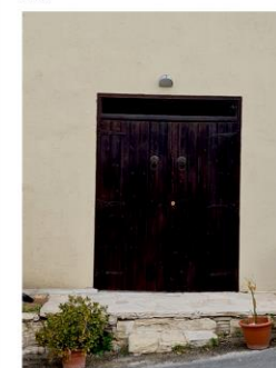
Θύρα με οριζόντιο ανώφλι με φεγγίτες (μεταγενέστερη προσθήκη)
