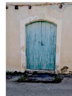
Θύρα με απόληξη χαμηλωμένου τόξου και περιθύρωμα με πελεκητή πέτρα
