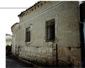
Συνδυασμός πέτρας στο κάτω μέρος με επιχρισμένο πλιθάρι στο πάνω μέρος
