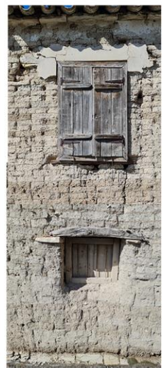
Οικοδομή 4- παραδοσιακό παράθυρο και μεταχενέστερο κλείσιμο
