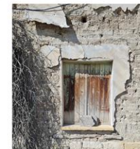
Οικοδομή 4- παραδοσιακό παράθυρο και μεταχενέστερο κλείσιμο
