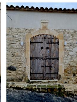
Θύρα με απόληξη χαμηλωμένου τόξου και περιθύρωμα με πελεκητή πέτρα
